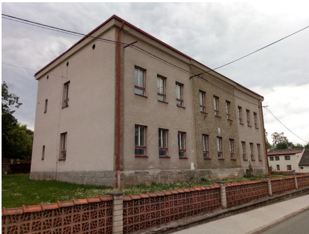
Obrázek 19: Budova bývalé školy – stav k červenci 2018
