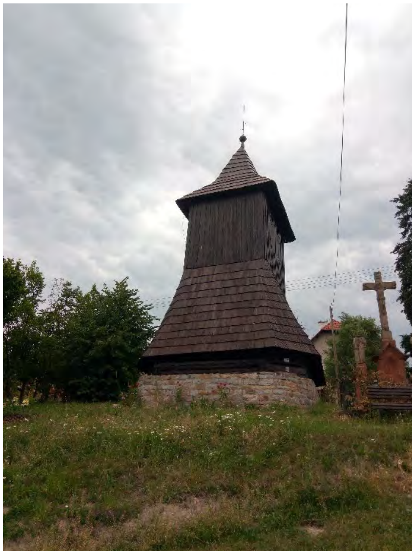
Obrázek 6: Slatinská zvonice – stav k červenci 2018
