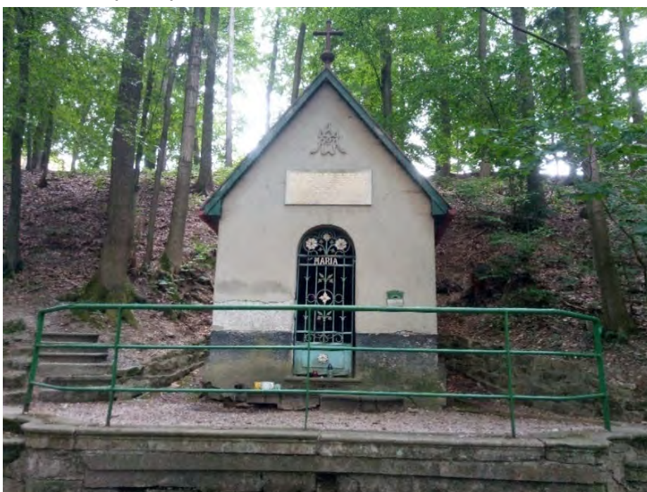
Obrázek 7: Mariánská kaplička pod Boušínem – stav k červenci 2018
