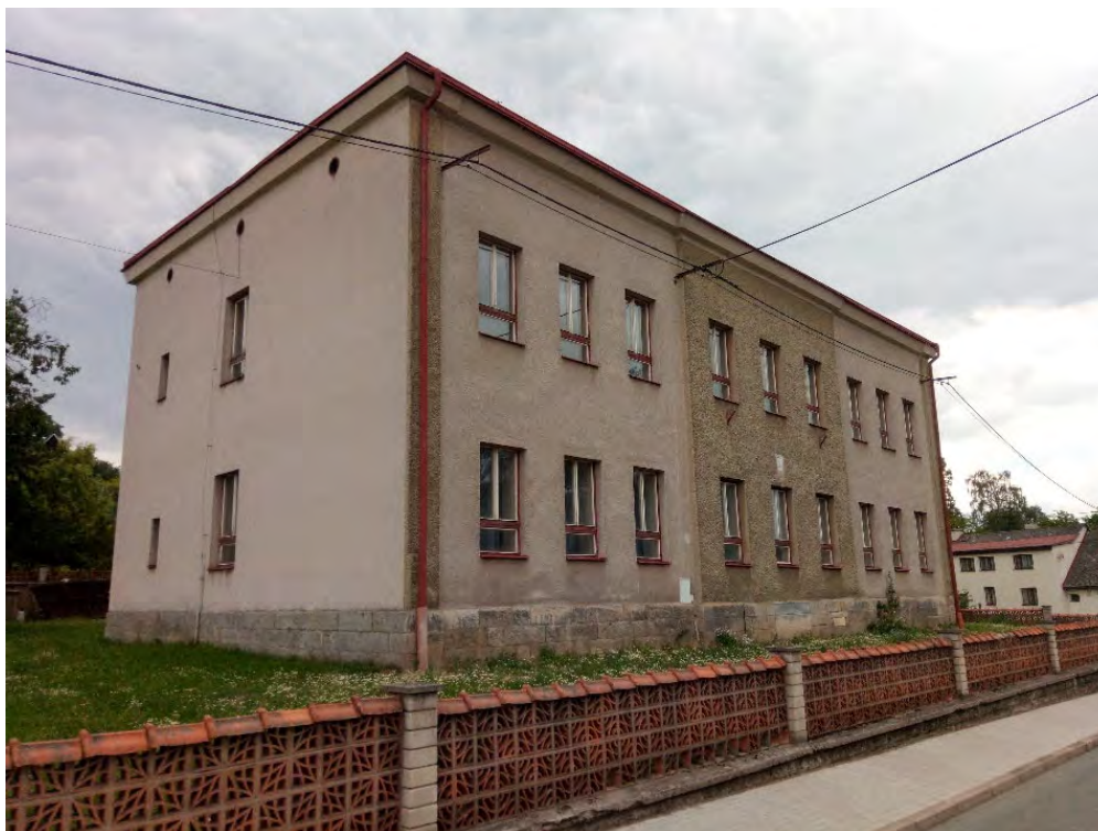
Obrázek 19: Budova bývalé školy – stav k červenci 2018
